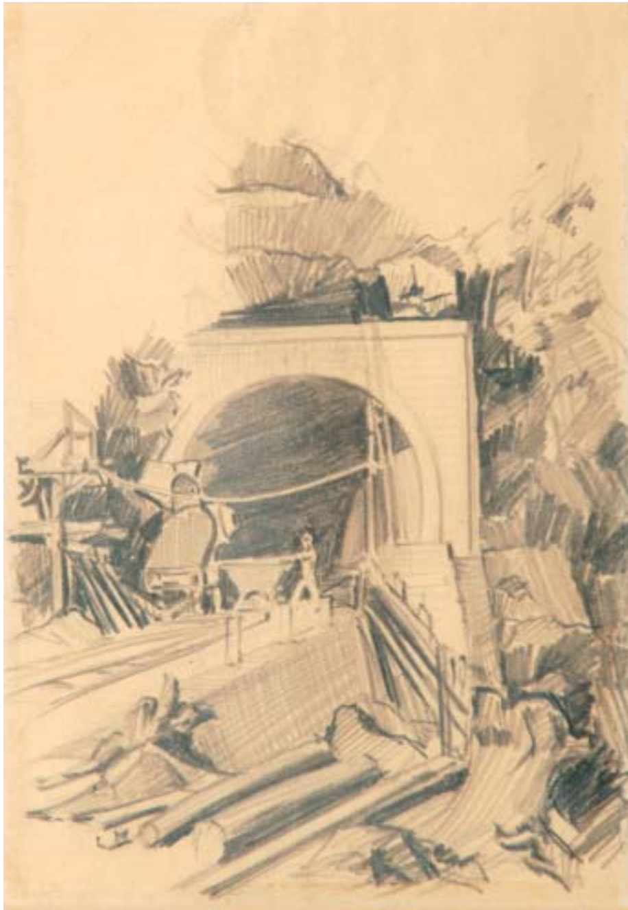
Lavori per la costruzione della galleria di Valfloriana matita e carboncino su carta cm 25x17 firma: assente Trento, collezione privata
